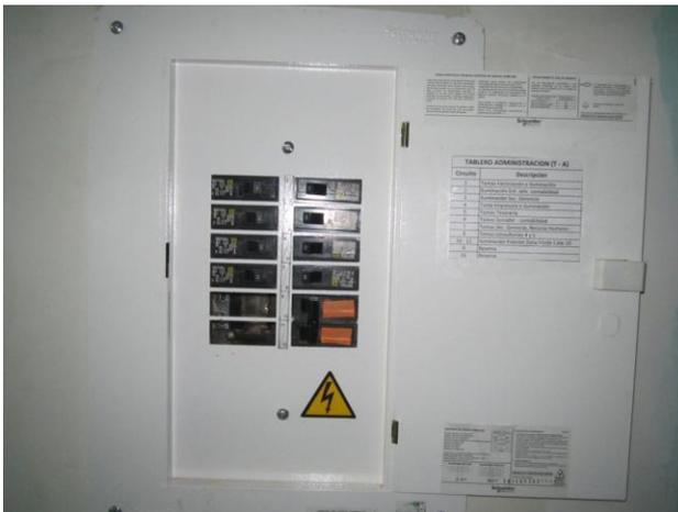
**Tablero trifásico de 12 circuitos instalado en el área de administración**
