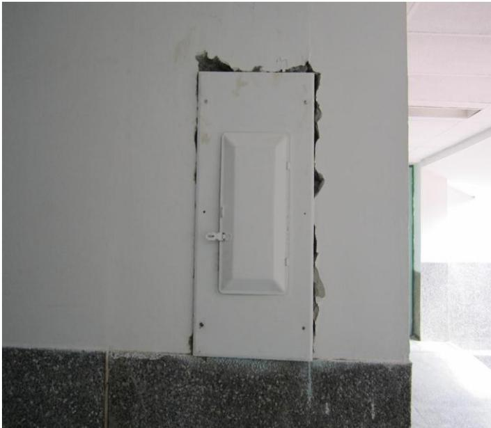
Retiro del tablero existente y montaje de un tablero trifásico con puerta de 18 circuitos, barraje de neutro y barraje de tierra, para alimentar los circuitos de iluminación y tomas normales del cuarto de motobombas, planta de emergencia, archivo, almacén, auditorio y área de odontología.
