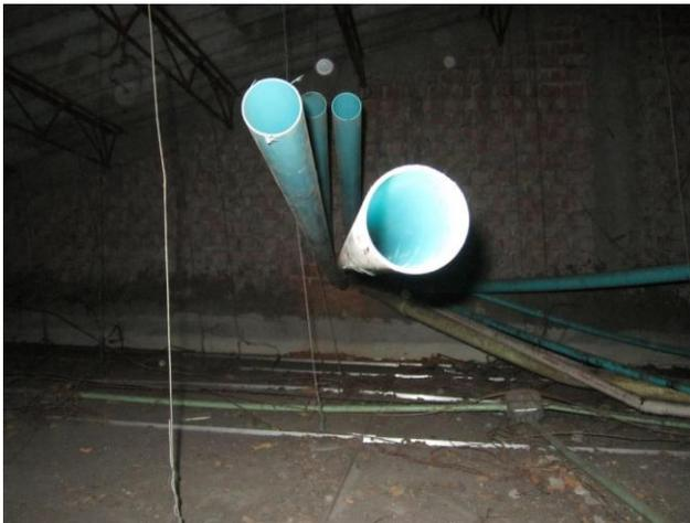
**Tendido de tubería para los circuitos de los tableros de administración, UPS, Partos y Hospitalización**
