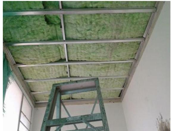
Una parte del área fue remodelada y otra fue adecuada, anteriormente estaba en muy mal estado, goteras, humedades, muchas oficinas tenían baños compartidos, paredes sucias, bóvedos con tejas rotas. Al remodelar todo esto cambio todos los bóvedos se hicieron lisos con panel yeso, las paredes se estucaron y pintaron.
